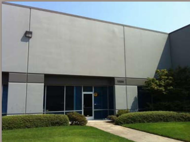
13233 NE Whitaker Way - Bldg. #6
